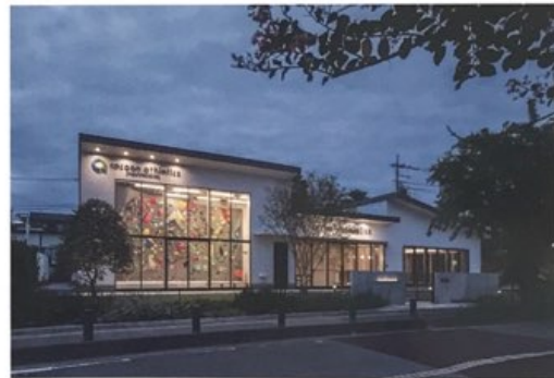
夜間はライトアップによりカラフルなホール드가目を惹く
